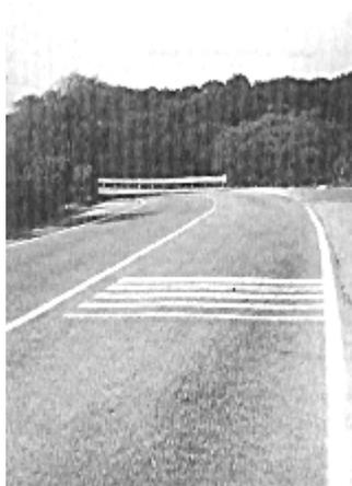
Sullo stesso principio si basano le rigature a “V”, con il vertice orientato nella direzione di marcia, a distanza reciproca progressivamente minore, che talvolta sono utilizzate in Francia, lungo le strade Nazionali o Dipartimentali, per indicare l'avvicinarsi di una zona di pericolo o di un tratto di strada con limiti di velocità ridotti. [7] (Figura 9.13).
